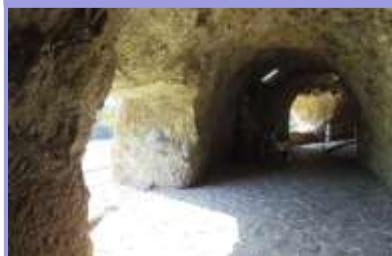
江戸時代に、ノミと鎚だけで30年余り掘り続けてきた、手彫りのトンネル。
